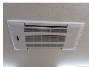
生活介護事務所エアコン取替
