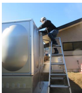
グループホーム夢ハウス スプリンクラー設置
